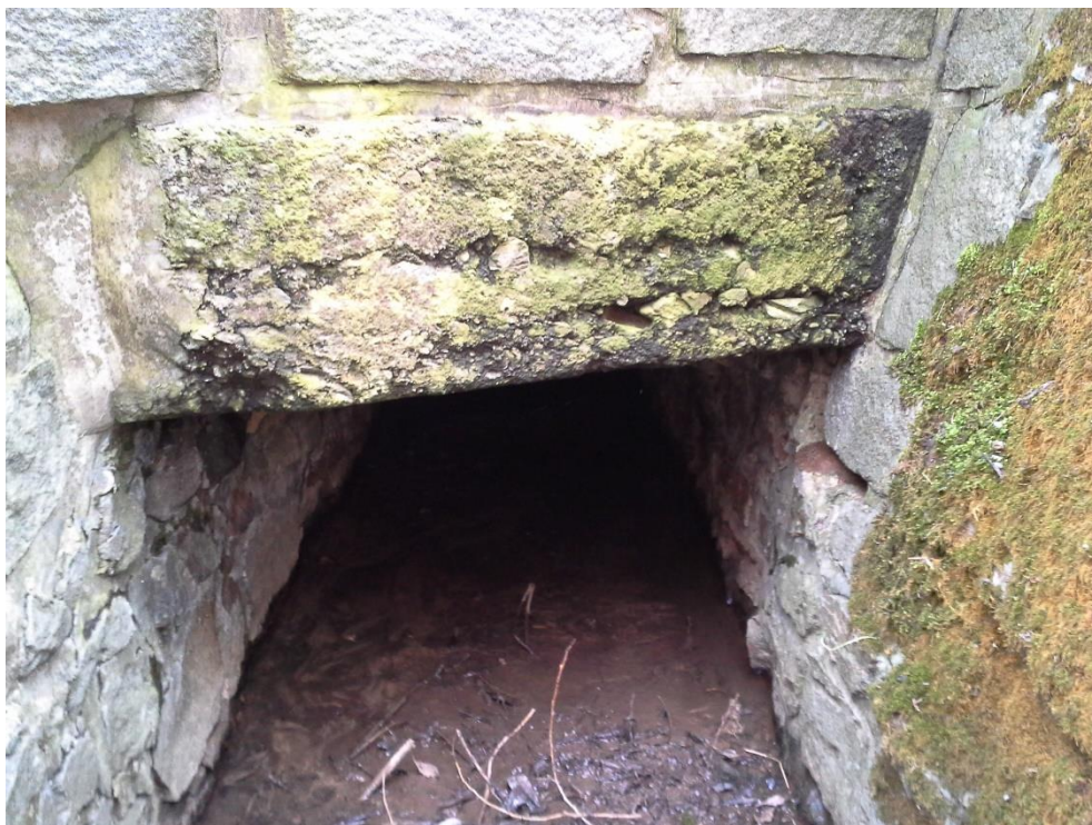
Foto 4: Vypadané spárování mezi kameny, křídla porostlá mechem
